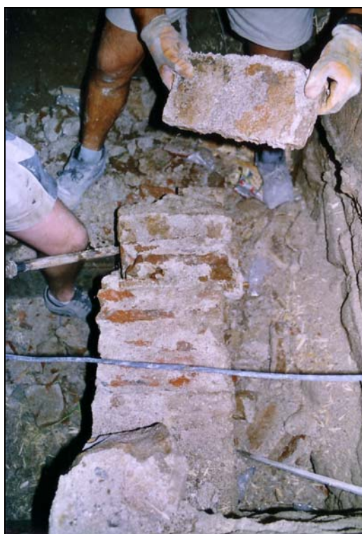
F9: Vista de la segona fase del pou durant el seu desmuntatge.
